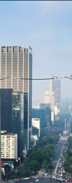
Zonas metropolitanas Cable ADSS Span 100 m Cable ADSS Antirroedor Cable ADSS Access
