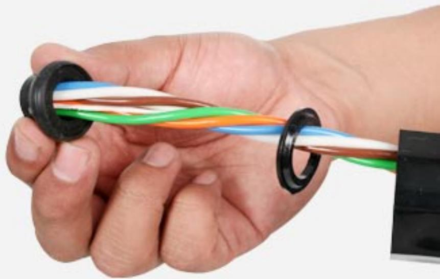
Cuando el cable esté desnudo, tome la tuerca y los sellos que quitó del puerto de la caja de empalme e insértelos en el cable de la siguiente manera, primero la tuerca, después el anillo y por último el empaque.
