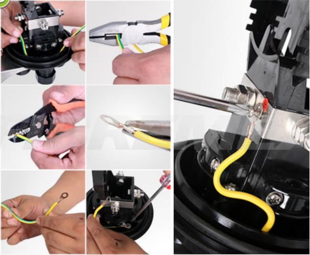
Empezamos por la instalación del cable de tierra identificando los dos bornes tipo oreja seguido de una medición aproximada del cable a utilizar y lo cortamos, con ayuda del pelador de cubiertas descubrimos 1 cm aproximadamente en ambos extremos.
